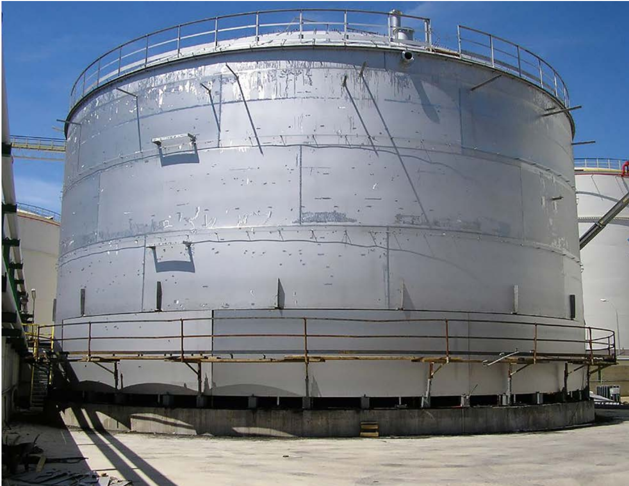
Serbatoio di stoccaggio in acciaio duplex 2304 dopo decapaggio.
